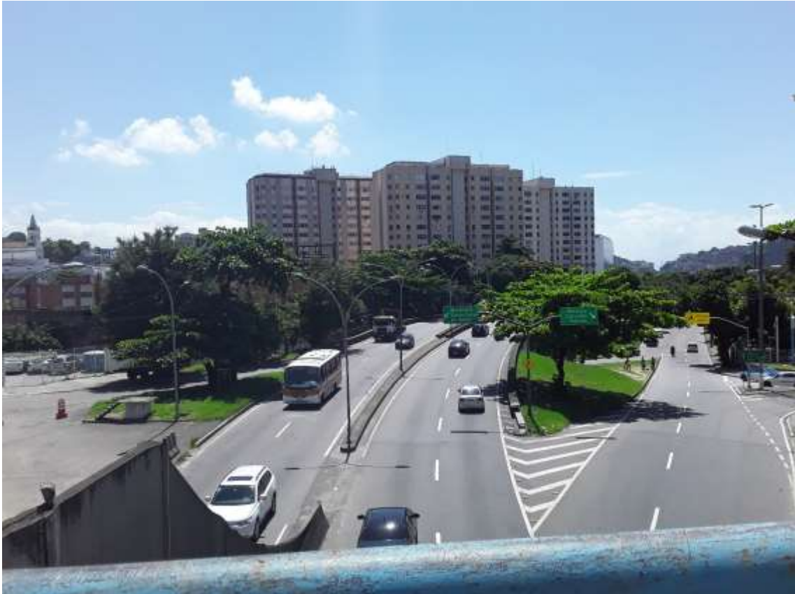
Figura 1. Viaduto da Linha Lilás: rompe a aparência de contiguidade do Catumbi, à esquerda, com o bairro adjacente de Santa Teresa, à direita. Ao fundo, os primeiros prédios construídos nas obras de reurbanização.
