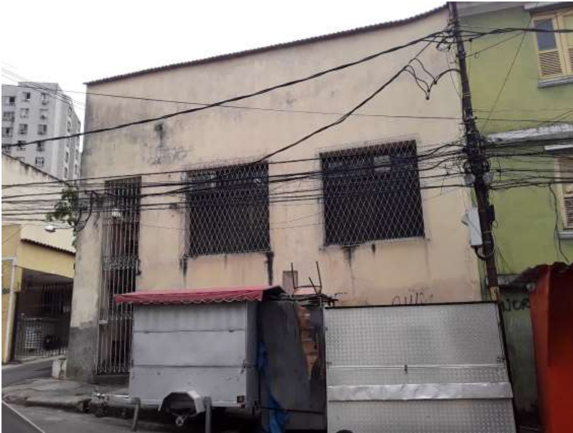
Figura 2. Sede da equipe regional do RJ do Movimento de Trabalhadores Cristãos. Não há uma placa ou outro tipo de identificação no local.
