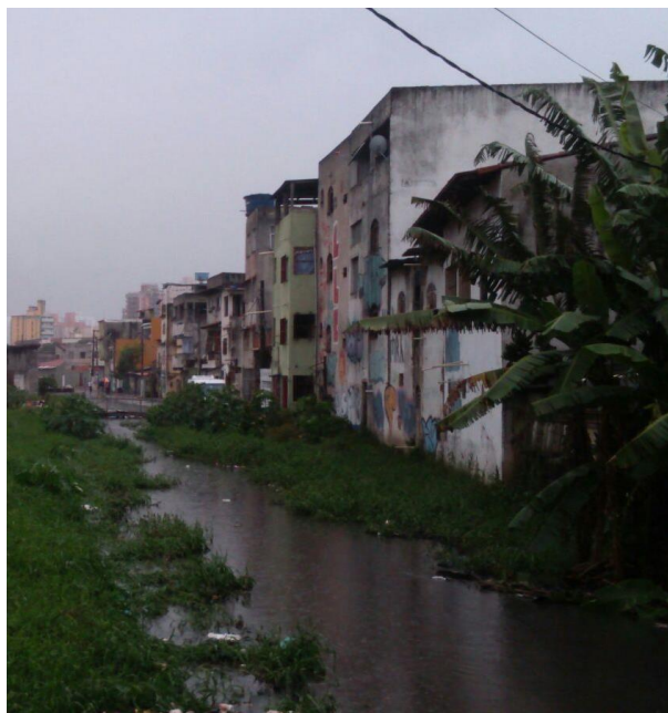
Figura 1 – Parcela da Rua Sta. Teresinha de frente para o Canal da Costa.
