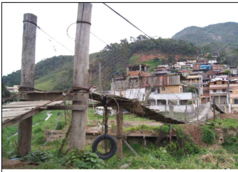
Fotografia 2: “Pinguela” construída pelos Moradores para a passagem entre os dois lados do bairro
