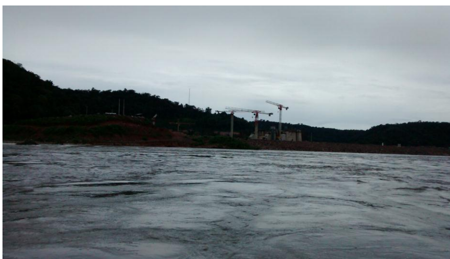
Figura 2. Hidrelétrica São Manoel em fase de construção (março/2016). Fonte : própria autora
