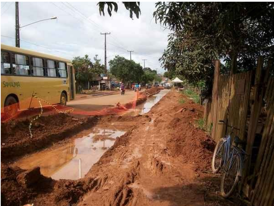
Foto 2. Obras de saneamento na Rua José Porfírio em março de 2014. Foto: Raoni Giralдин
